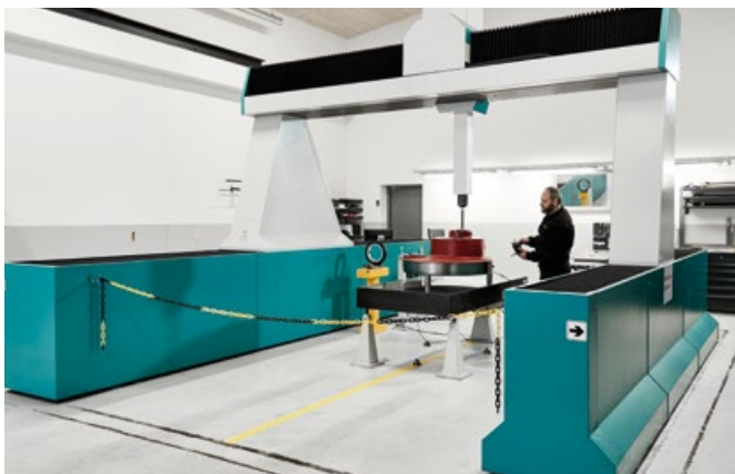
Specialindrettet bygning designet til måleteknik herunder vibrationsfrit fundament.
